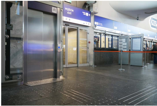
Dźwigi osobowe, system fakturowych oznaczeń nawierzchniowych
